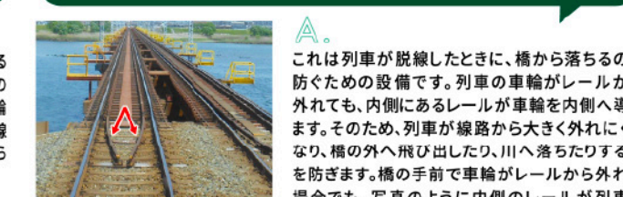
橋梁の脱線防止レール
