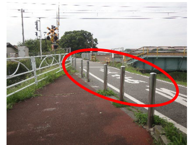
進入路に規制杭を設置した夢前川東詰踏切
