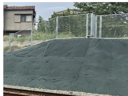
霞ヶ丘駅―舞子公園駅間の立入防止柵
