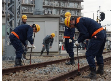
線路復旧作業
