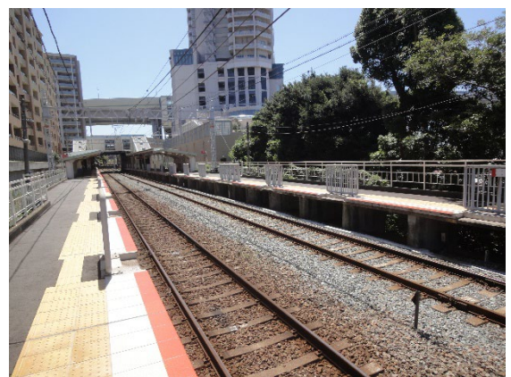
改良された舞子公園駅ホーム
