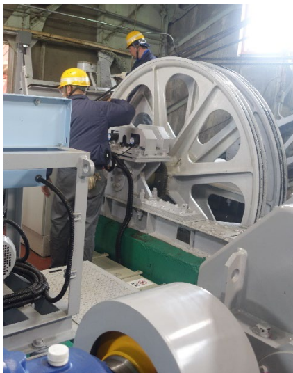
ロープウェイ原動滑車の点検状況
