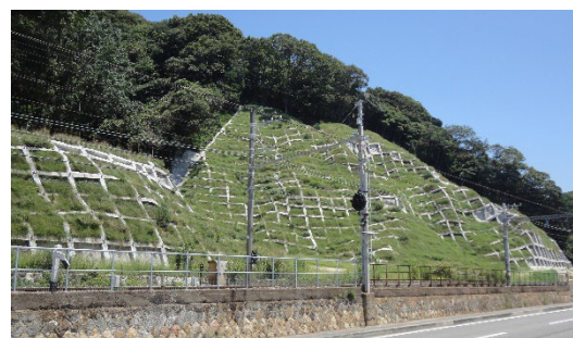
完成した法面防護工事
