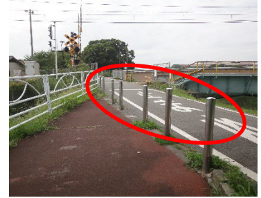
進入路に規制杭を設置した夢前川東詰踏切
