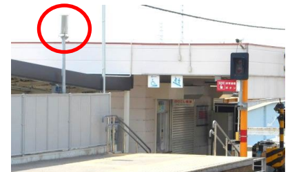
駅に設置している雨量計
