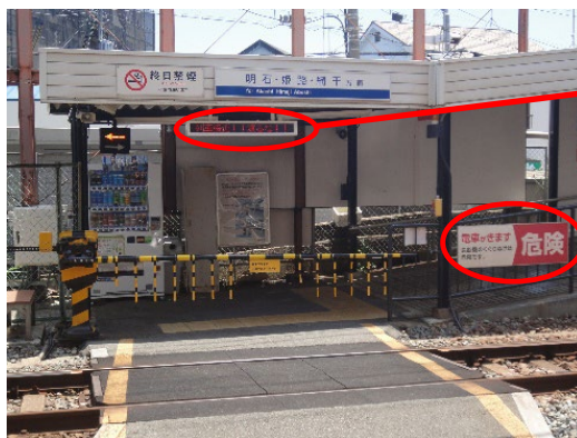
須磨寺駅渡線道に設置している安全設備
