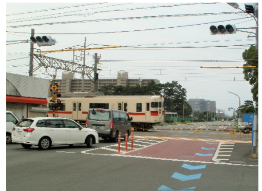
立体交差化が計画されている神鋼前踏切
