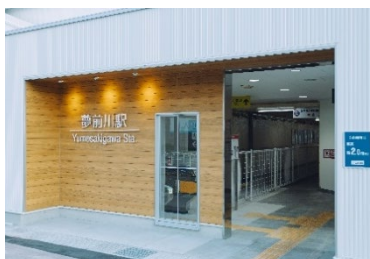
新設された南口
