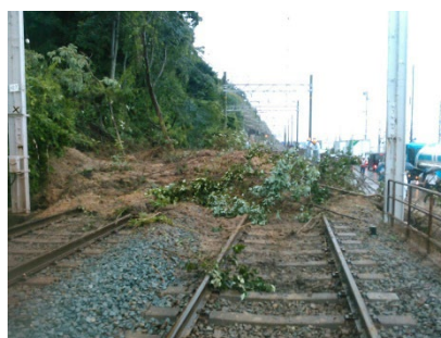
崩落直後の様子
