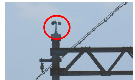
橋りょう上に設置している風速計
