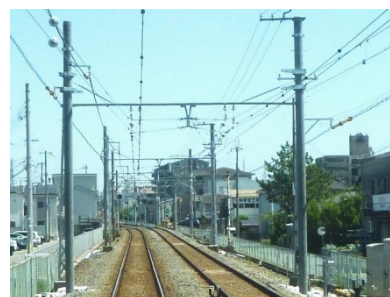
別府駅一浜の宮駅間支持物更新箇所
