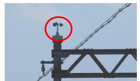
橋りょう上に設置している風速計
