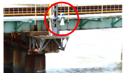
橋りょうに設置している水位計
