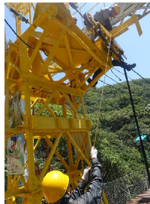
観光リフトの受索輪の交換作業
