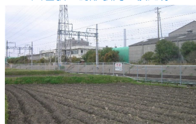
林崎松江海岸駅―藤江駅間の立入防止柵
