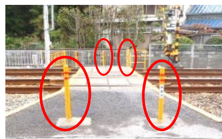
規制杭を設置した的形地蔵前踏切
