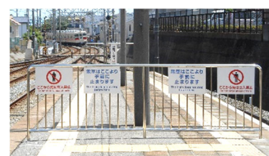
設置したホーム端部安全柵
