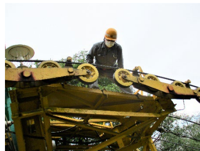
観光リフトの受索輪の点検状況
