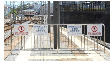
設置したホーム端部安全柵
