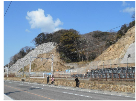
須磨浦公園駅－山陽塩屋駅間法面防護工事
