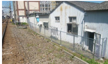
尾上の松駅－高砂駅間の立入防止柵
