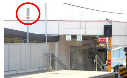
駅に設置している雨量計
