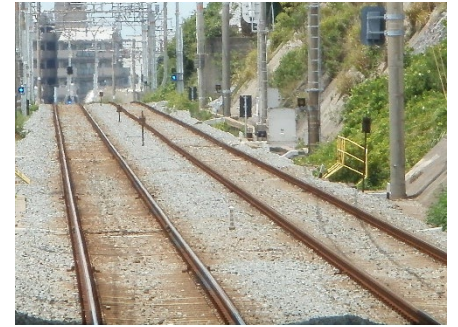
山陽塩屋駅―東垂水駅間の更新箇所
