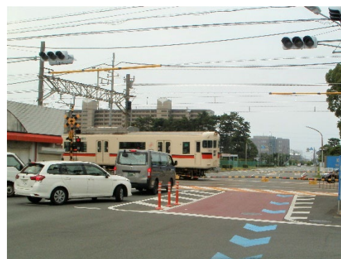
立体交差化が計画されている神鋼前踏切
