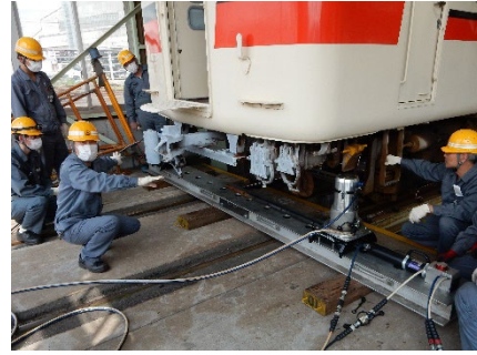
脱線復旧訓練
