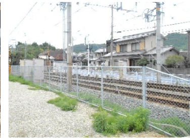
的形駅—八家駅間の立入防止柵
