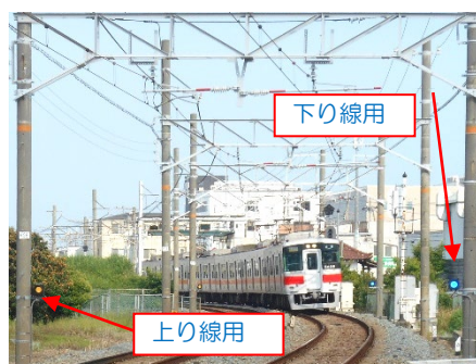
江井ヶ島駅付近の列車接近警報装置
