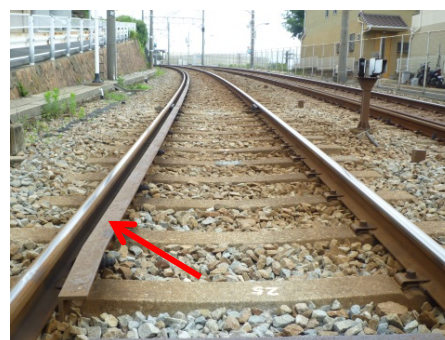
東垂水駅付近の脱線防止ガード
