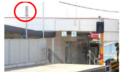
駅に設置した雨量計
