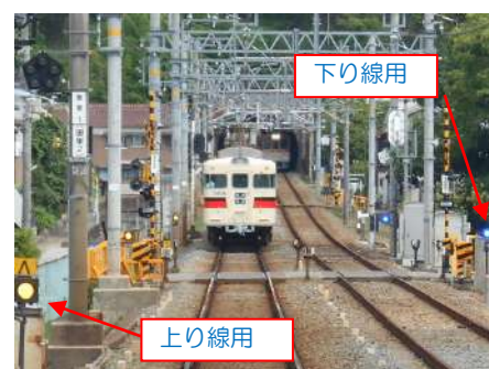
妻鹿駅付近の列車接近警報装置
