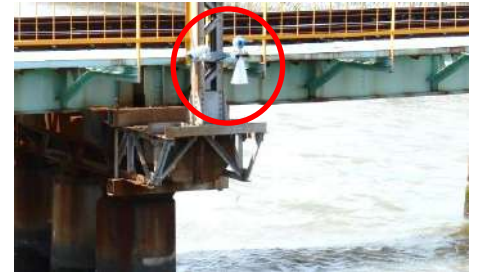
橋りょうに設置した水位計
