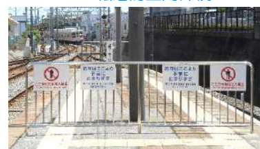
設置したホーム端部安全柵
