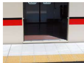
段差を解消した江井ヶ島駅
