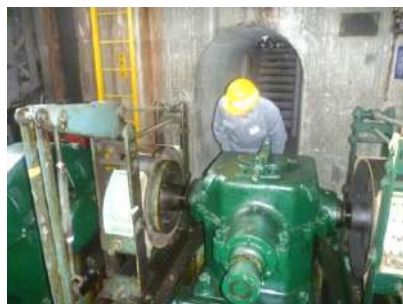
ロープウェイ制動機の点検状況
