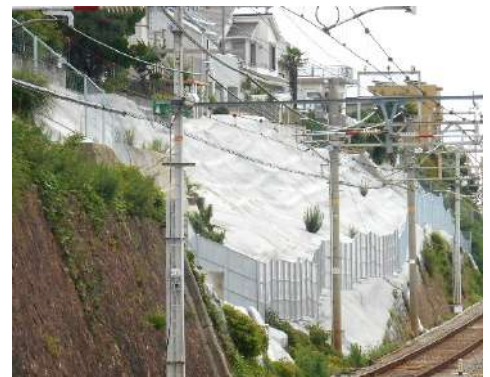
東垂水駅東方法面防護工事
