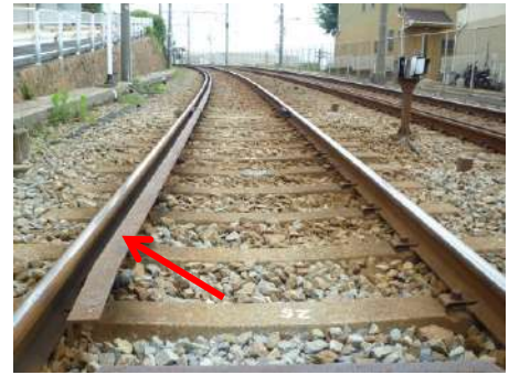
東垂水駅付近の脱線防止ガード
