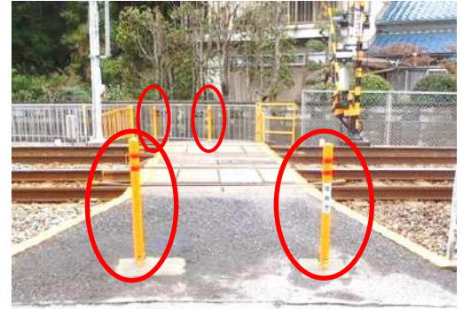
規制杭を設置した的形地蔵前踏切
