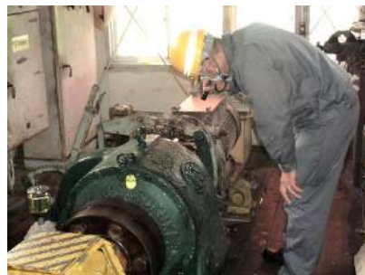
観光リフト原動機の点検状況
