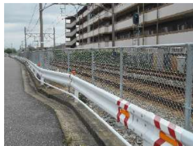
藤江駅—中八木駅間の立入防止柵
