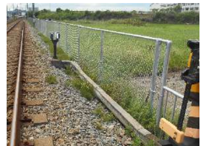
東二見駅—西二見駅間の立入防止柵
