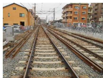
山陽魚住駅付近のレール更新
