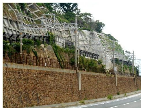
法面防護工事
