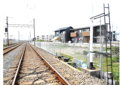
中八木駅～江井ヶ島駅間の立入防止柵
