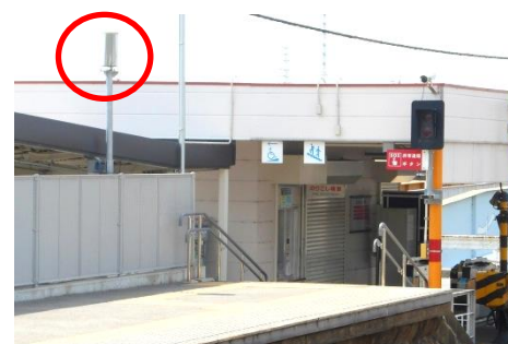
駅に設置した雨量計
