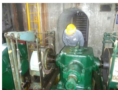
ロープウェイ制動機の点検状況
