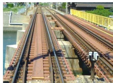
天川橋りょう下り線 まくらぎ更新箇所
