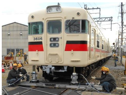
車両復線作業
