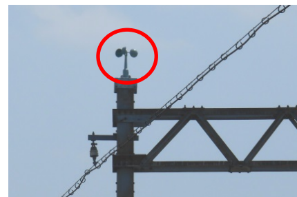
橋りょう上に設置した風速計
