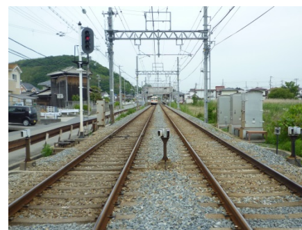
的形駅付近のレール更新箇所
