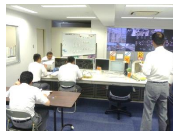
運転指令室における実設訓練
