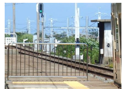
設置したホーム端部安全柵
