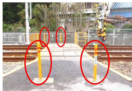
規制杭を設置した的形地蔵前踏切
