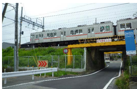
西江井ヶ島駅～魚住駅間の立入防止柵
