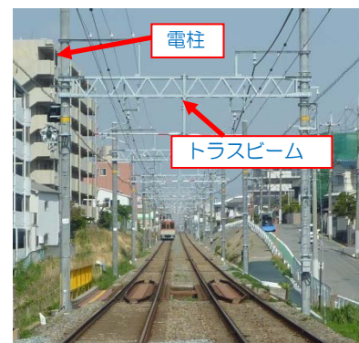
更新された江井ヶ島駅～西江井ヶ島駅間の支持物
