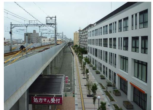
側道が整備された西新町駅付近
