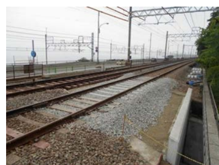
コンクリート製となった境川橋りょう (工事中的のようす)
