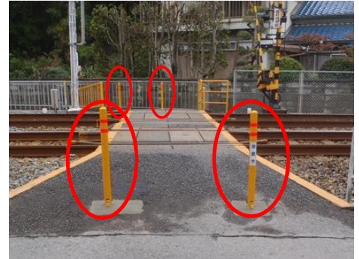
規制杭を設置した的形地蔵前踏切
