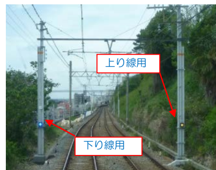
東垂水駅付近の列車接近警報装置
