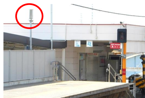
駅に設置した雨量計
