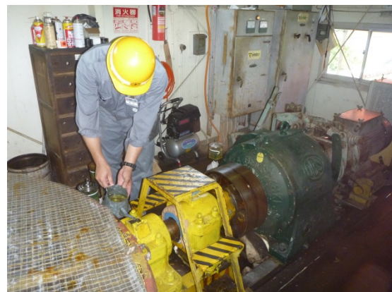
観光リフト原動機の検査状況
