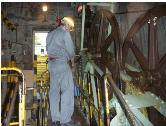
ロープウェイ平衡索用滑車の点検状況
