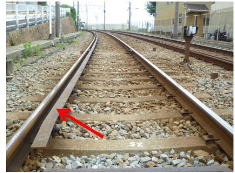
東垂水駅付近の脱線防止ガード
