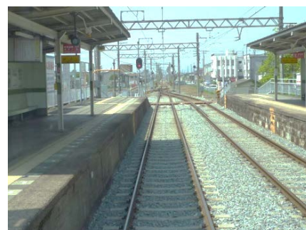
天満駅下り線 まくらぎ更新箇所
