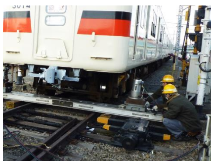
車両復線作業
