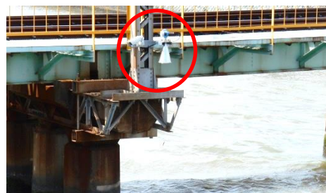
橋りょうに設置した水位計
