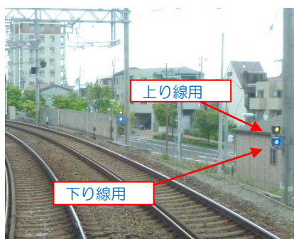
須磨寺駅付近の列車接近警報装置
