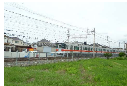
西二見駅～播磨町駅間の立入防止柵
