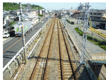
大塩駅付近のレール更新箇所
