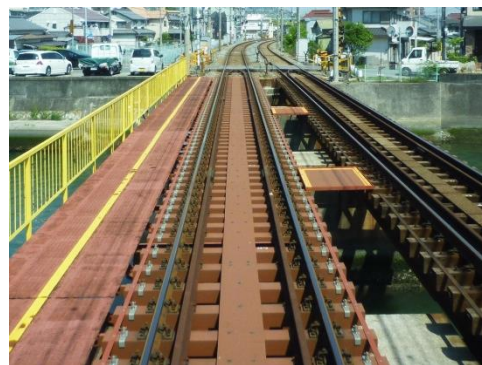
天川橋りょう上り線 まくらぎ更新箇所
