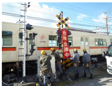
踏切復旧作業
