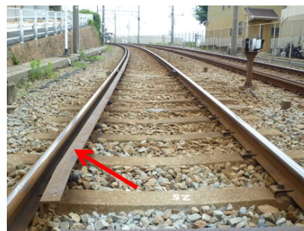
東垂水駅付近の脱線防止ガード
