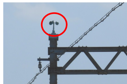
橋梁上に設置した風速計
