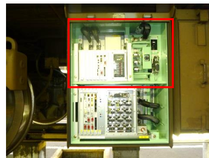
運転状況記録装置
