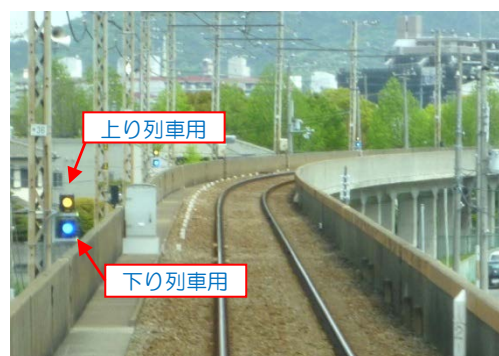
加茂第一架道橋付近の列車接近警報装置
