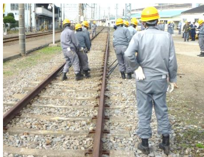
軌道復旧作業
