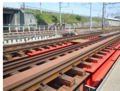
更新された山田川橋梁の桁
