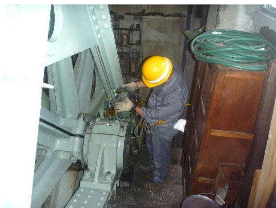
ロープウェイ緊張索用滑車の点検状況
