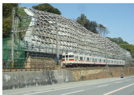
法面防護工事の状況
