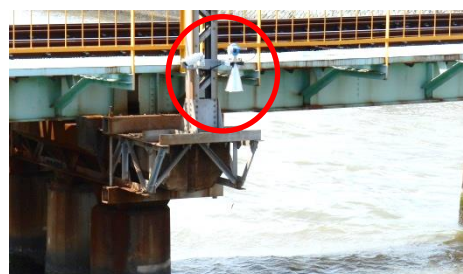
橋梁に設置した水位計
