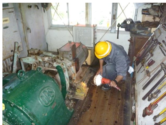
観光リフト原動機の検査状況
