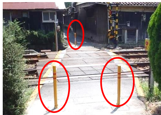
規制杭を設置した中野踏切道
