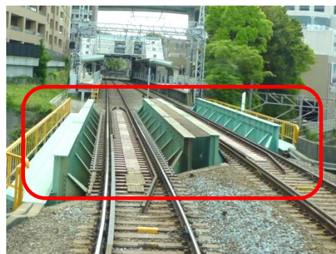
まくらぎを更新した舞子線路橋
