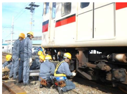
車両復線作業
