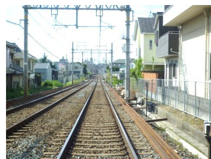
西江井ヶ島駅付近のレール更新工事
