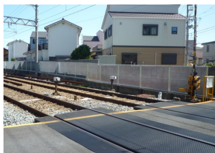
林崎松江海岸駅西方の立入防止柵
