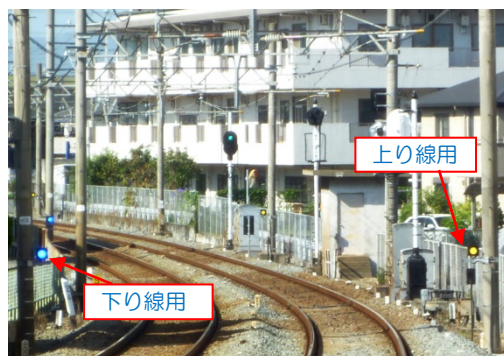
伊保駅付近の列車接近警報装置
