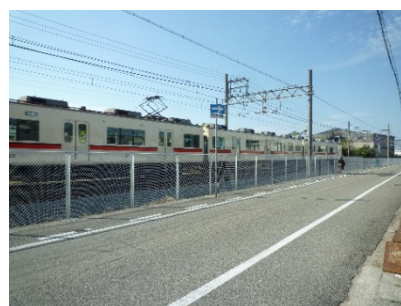
荒井駅～伊保駅間の立入防止柵
