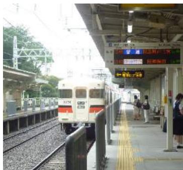
舞子公園駅固定式ホーム柵
