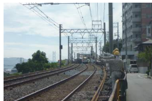
塩屋駅～滝の茶屋駅間のレール更新工事
