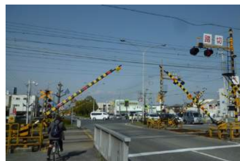
大口径遮断桿とオーバーハング型警報装置
