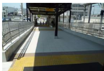
ホーム段差解消・スロープ改良（網干駅）
