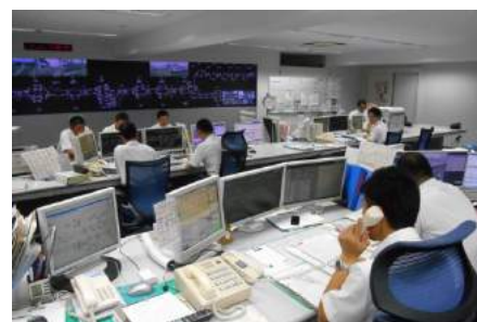
運転指令室における実設訓練
