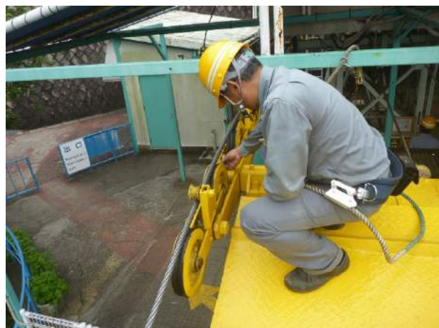
観光リフト受索輪の溝の点検状況
