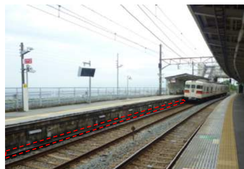
滝の茶屋駅のホーム下に設置している検知マット
