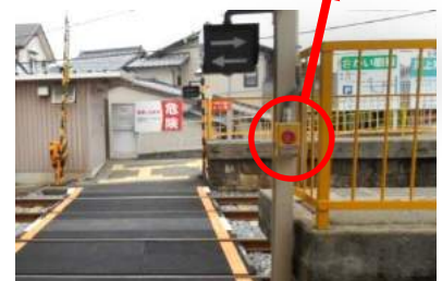
伊保駅渡線道に設置した非常通報ボタン
