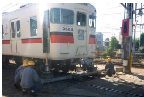
車両復線作業
