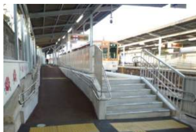
ホーム段差解消・スロープ改良（月見山駅）
