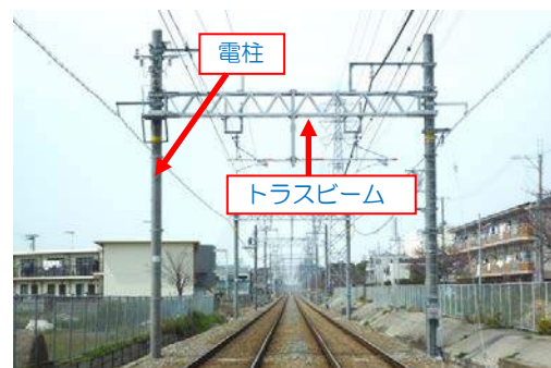
更新された林崎松江海岸駅～藤江駅間の支持物
