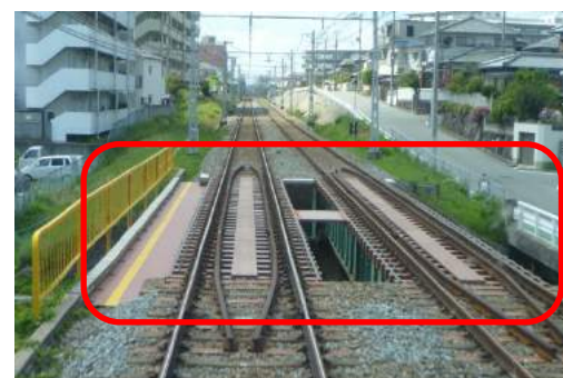
まくらぎを更新した柳井川橋梁
