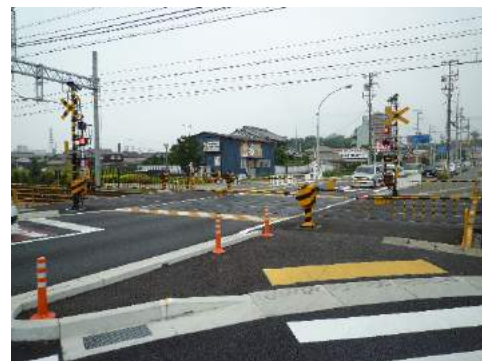
歩道部分を拡幅した市役所北通踏切道
