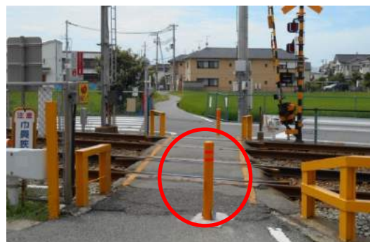
規制杭を設置した古宮踏切道
