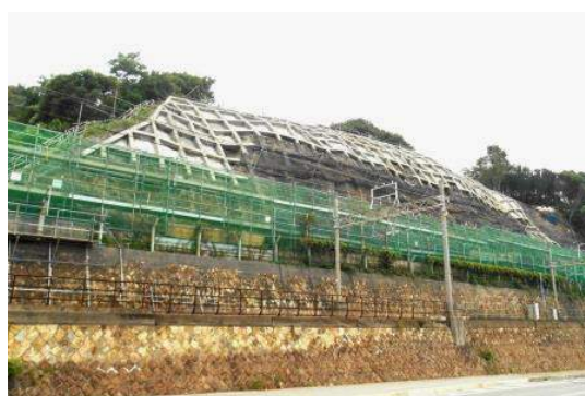
法面防護工事の状況
