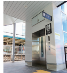
エレベーター
