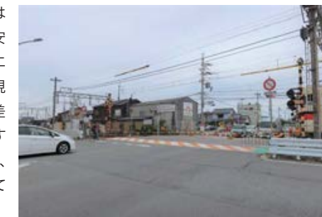
立体交差化が計画されている神鋼前踏切
