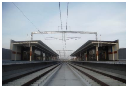
<西新町駅高架部>
