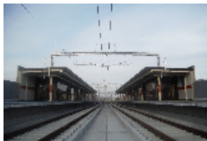
<西新町駅高架部>
