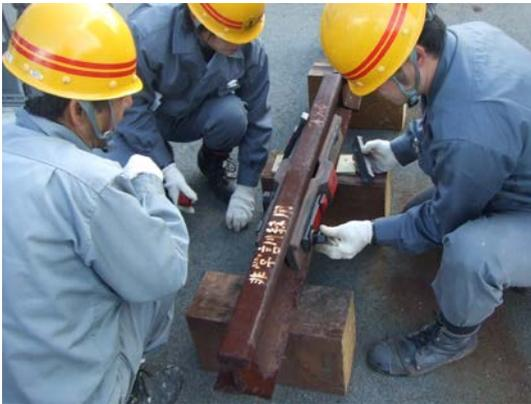
レール折損時の応急処置訓練
